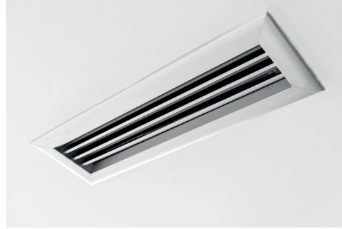
Figura 2.6. Rejilla de impulsión.
